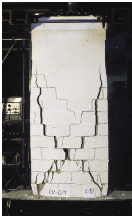
Slika 30 • Zid, armiran samo z robno navpično armaturo, se je porušil strižno. (Fotografija: M. Tomažević)
