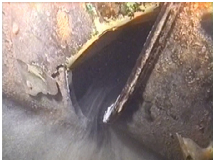
Slika 6 • Odprtina namesto naprave za odvod plinov na prvem grebenu zah. kraka natege.
