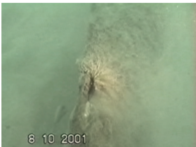
Slika 7 • Nasilna odprtina na vzh. kraku za napačni zajem vode nad dnom jezera.
