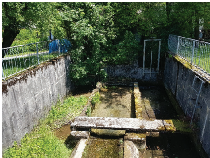
Slika 5 • Že obstoječi objekt za bifurkacijo Mišce, s katerim so jo delno speljali v jezero, delno pa po naravnem koritu v Savo Dolinko.
