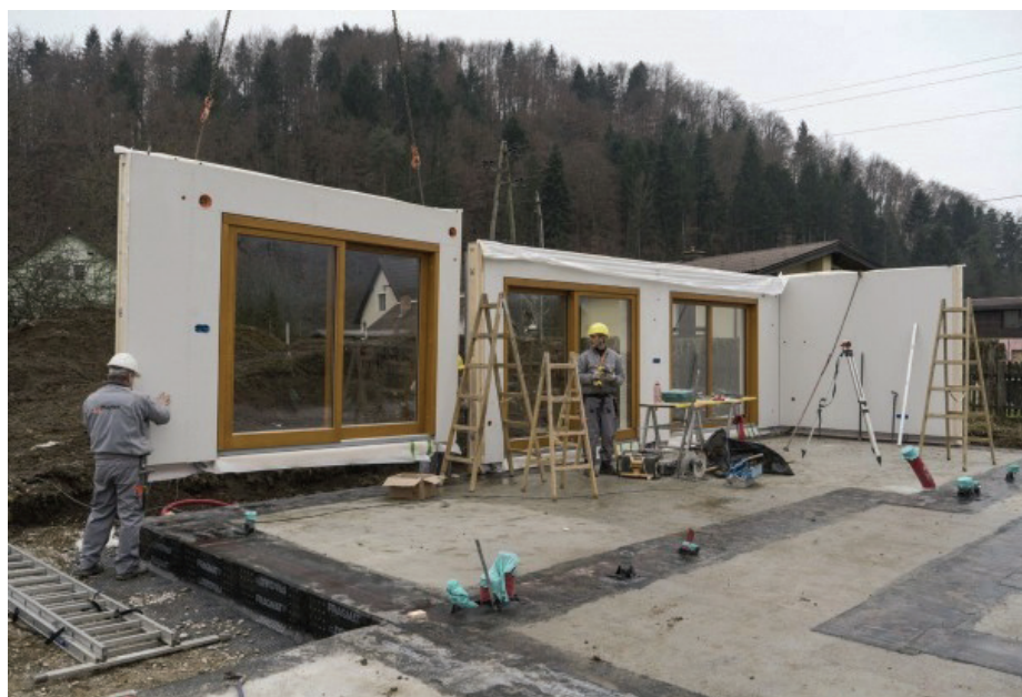
Slika 2 • Montaža stenskih panelov (Marles, 2019).
