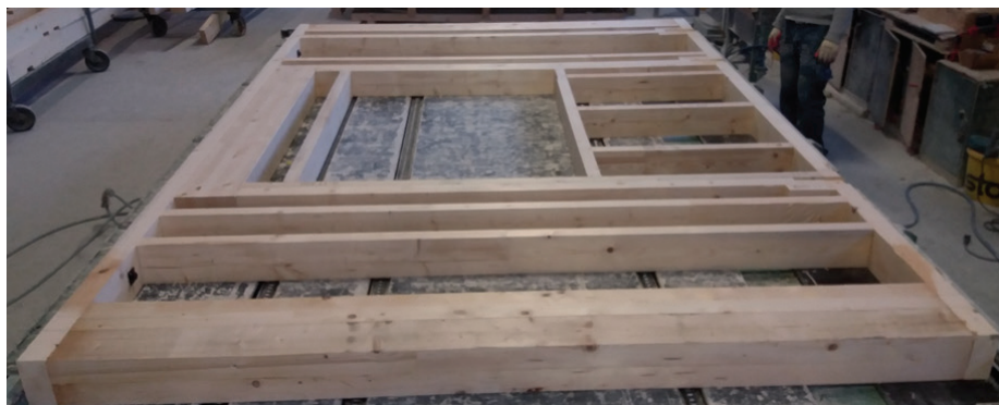
Slika 15 • Dokončana lesena nosilna konstrukcija stenskega elementa.
