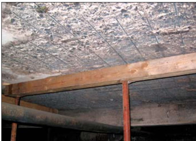
Po požaru v garaži v Zupančičevi jami; posledice požara enega osebnega avtomobila
