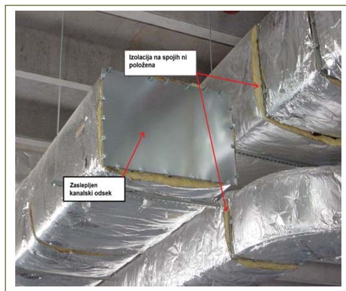
Slika 3: Pravilno pripravljen odsek zračnih kanalov za izvedbo »DALT«.
