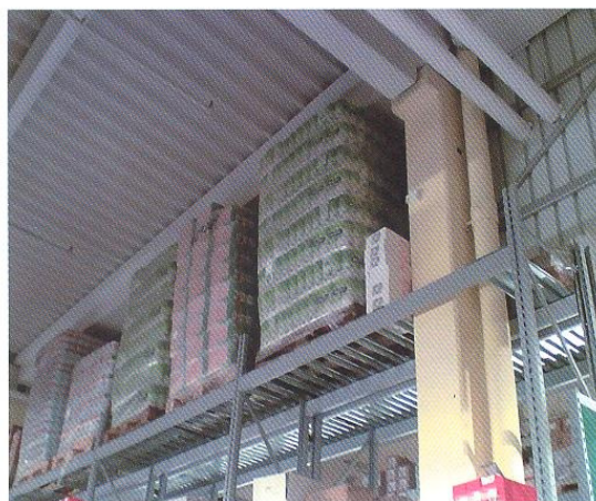
Slika 6: Primer previsokega skladiščenja v regalnem skladišču, zaščitenem s sprinklerskim sistemom
