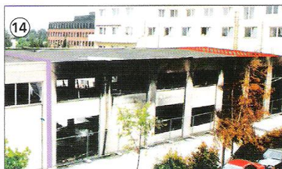
Pravilna izvedba požarno odporne strehe (Brandschutzatlas, FeuerTRUTZ)
