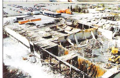
Požar hale velikosti 8.500 m 2 (Brandschutzatlas, FeuerTRUTZ)
