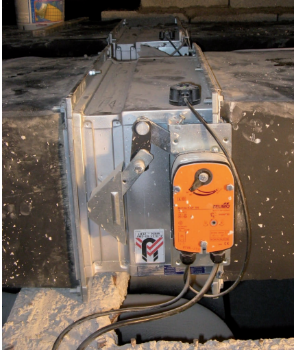
Slika 9: Požarna loputa je vgrajena kar mimo požarnega zidu
