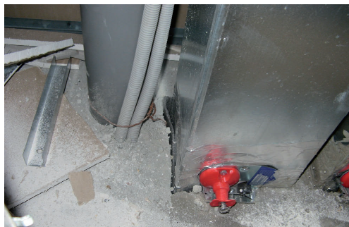
Slika 7: Običajna vgradnja požarne lopute in prehodi instalacij skozi požarne stene: nered, ni požarne zatesnitve, ni ploščice izvajalca...itd.
