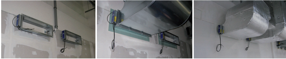
Slika 8: Pravilni postopek pregleda vgradnje APZ – ves čas pod nadzorom odg. nadzornika požarne varnosti
