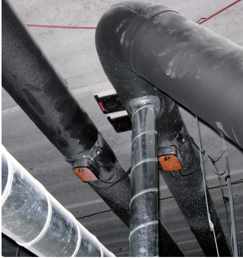
Slika 12: Požarne lopute so vgrajene kar v zraku, kjer ni požarnega zidu!
