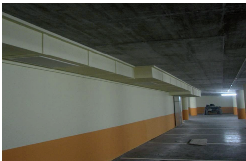
Slika 74: Klasični primer izvedbe MODT v garažah (požarni kanali za ODT)
