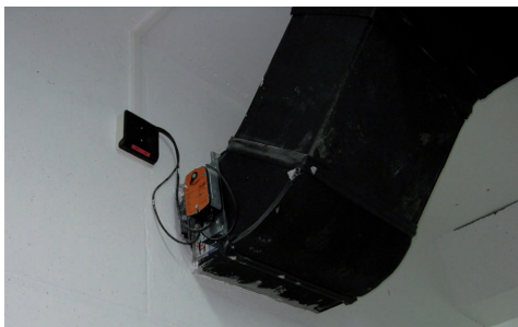
Slika 5: Pravilna vgradnja požarne lopute, manjka pa podatek o izvajalcu in sistemu požarne zatesnitve
