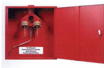
Slika 141: Mesto za dovod vode
