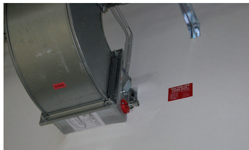
Slika 6: Pravilna vgradnja požarne lopute
