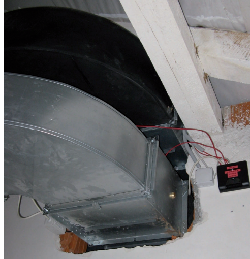
Slika 10: Klasična napaka: požarna loputa je vgrajena, ker pač mora biti, zatesnjena pa ni
