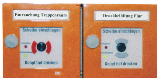
Slika 211: Ročna javljalnika za daljinsko električno proženje NODT in NKD s potrebnimi lučkami in oznakami po nemškem standardu VdS 2592 (oranžne barve), z napisom, kaj in kje se bo zgodilo (odvod dima iz stopnišča oz. nadtlačna kontrola dima na hodniku)
