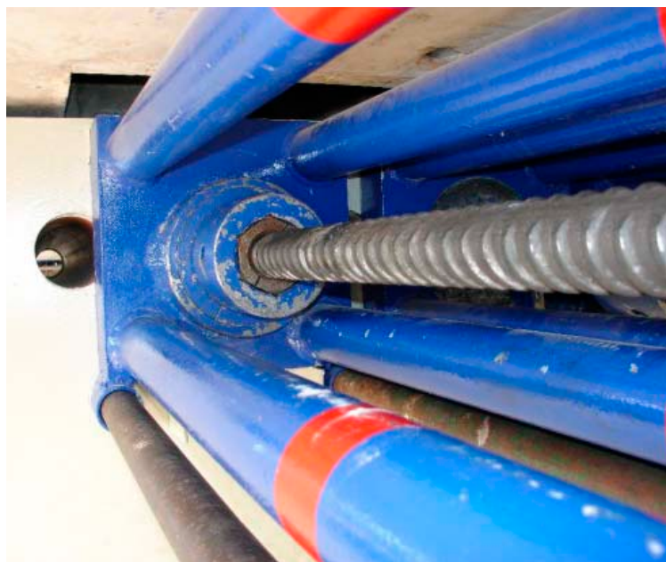
Slika 8: prerezana matica in podložka z objemkami v "kletki" med varovanjem
