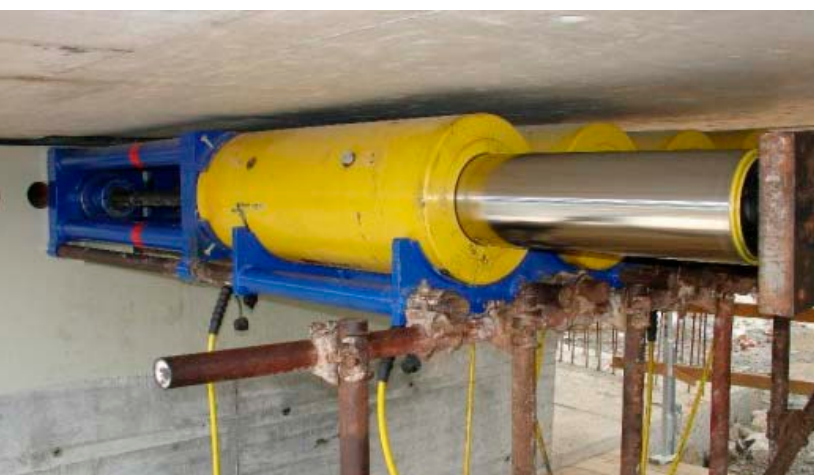
Slika 9: vlečni mehanizem v delovanju - viadukt Polance
