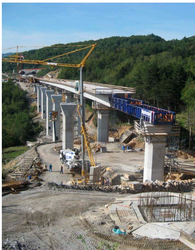
Slika 10: Viadukt Polance v fazi narivanja desne polovice
