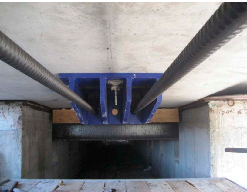
Slika 7: vpetostni element pred začetkom vlečenja - pogled v smeri delavnice
