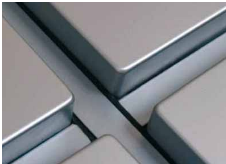
Slika 9: Spoj fasadnih elementov
