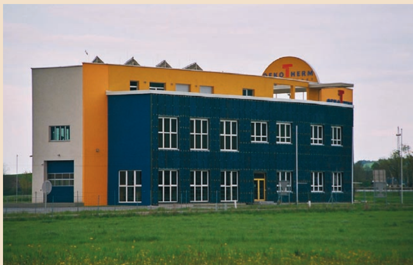
Slika 5: Integracija fasadnih elementov za pridobivanje energije iz sončne energije.
