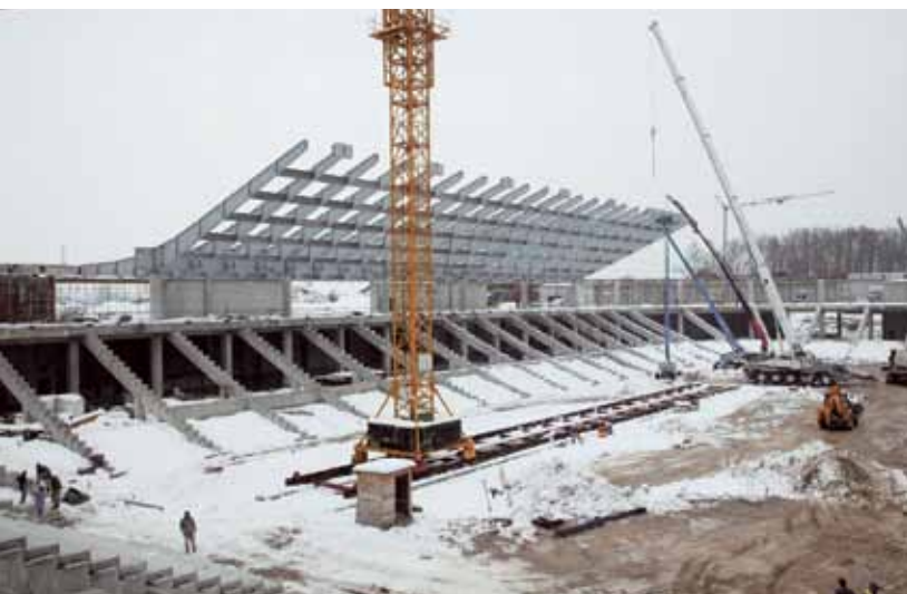
Slika 3: Montaža jeklene strešne konstrukcije na stadionu
