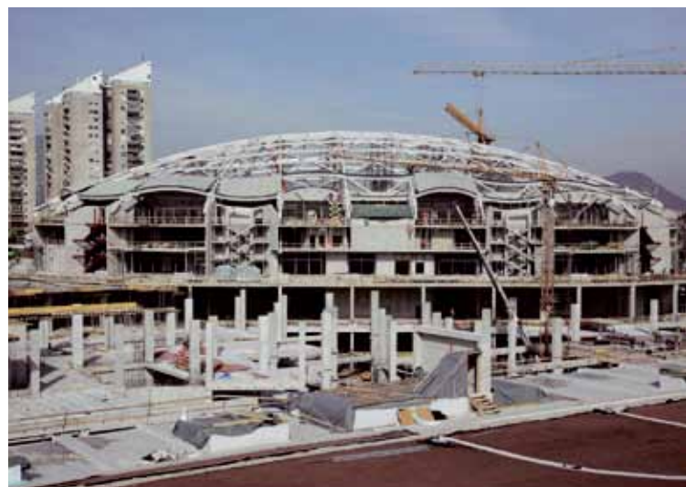
Slika 4: Pogled na gradbišče dvorane
