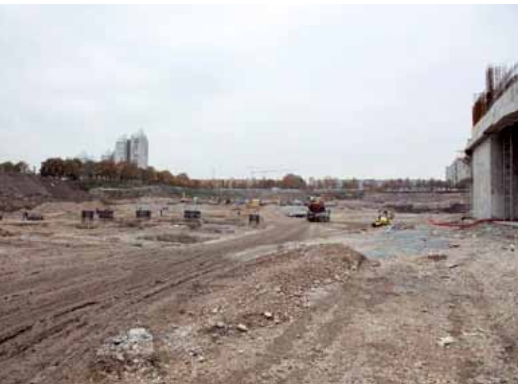
Slika 5: Priprava temeljnih tal, zasip med temelji trgovskega centra
