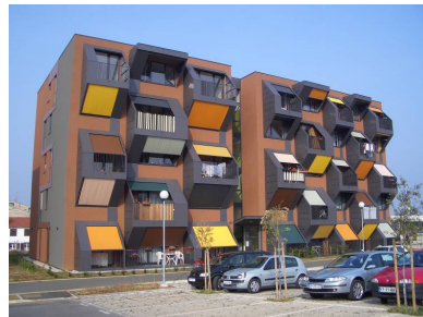
Slika 1. Zasnova ovoja stavbe in senčenje zastekljenih površin vpliva tudi na potrebe po hlajenju.
