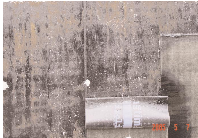
Slika 1: Vgrajevanje hidroizolacije na neustrezno podlago
