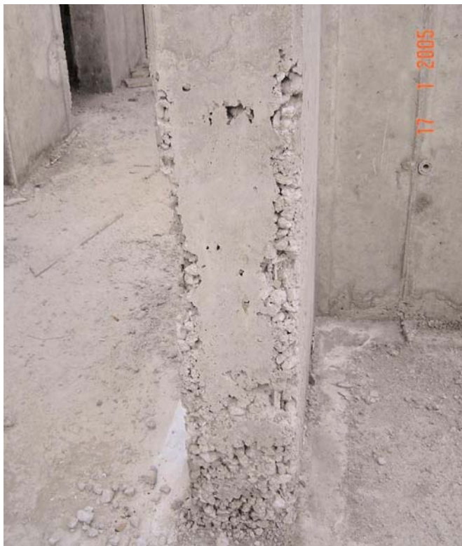
Slika 2: Segregirana betonska stena
