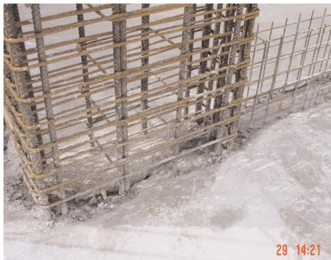
Slika 3: Pomanjkljivo vgrajena armatura
