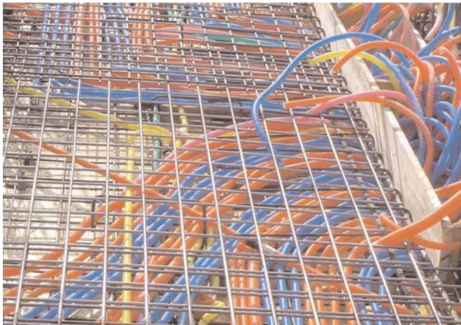
Slika 4: Inštalacijski vodi pred betoniranjem
