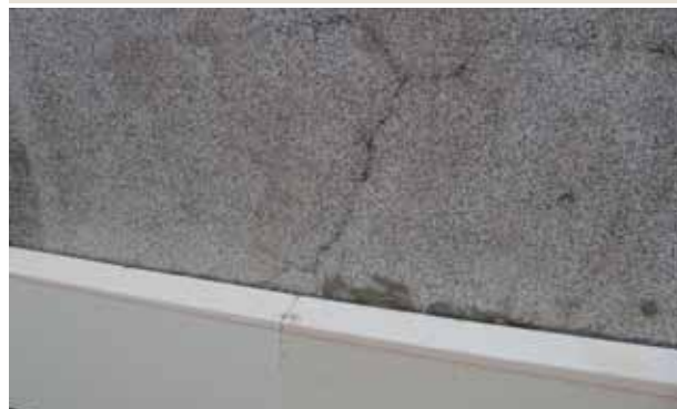
Slika 2 Potemkinova prenova: zakrivanje konstrukcijskih razpok nosilne fasadne stene s toplotno izolacijo. Subvencija Ekosklada.
